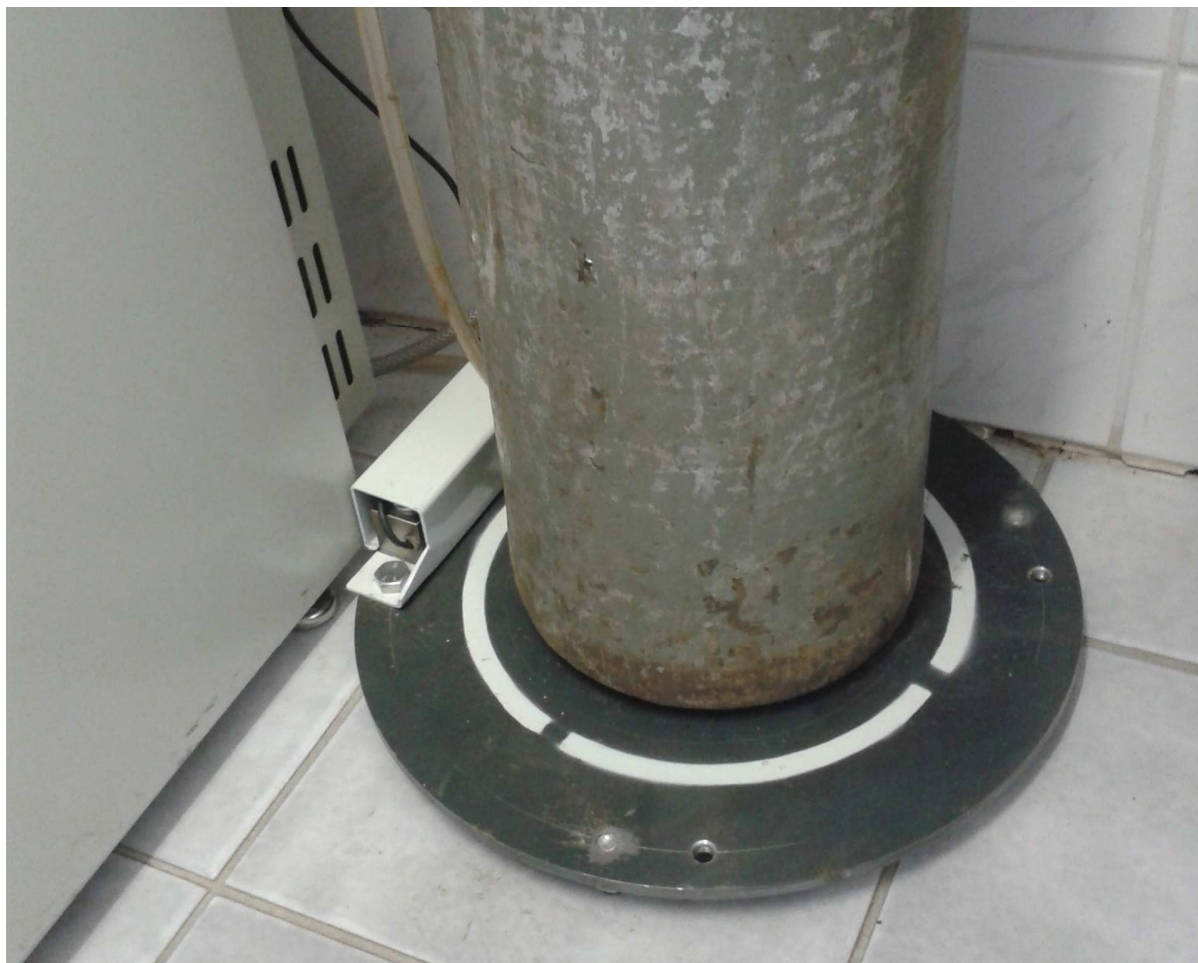
Zdjęcie z instalacji w jednym z Instytutów Biotechnologicznych. Waga dla butli dostarczającej CO 2 do inkubatora.
